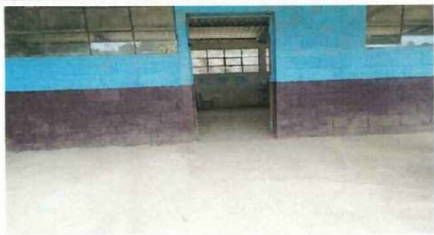
Foto1: COLOCACIÓN DE PISO CERÁMICO, CAMBIO DE PUERTA Y PINTURA AULA No. 1
