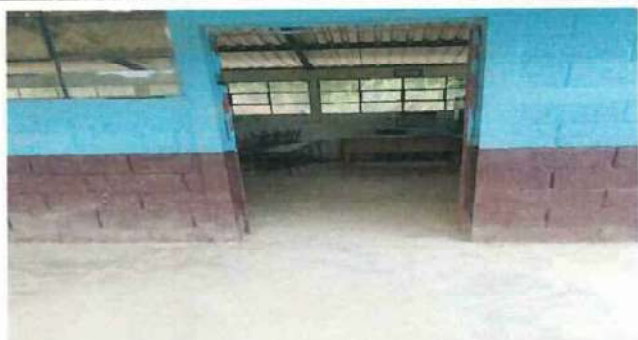
Foto 3: COLOCACIÓN DE PISO CERÁMICO, CAMBIO DE PUERTA Y PINTURA AULA No. 3
