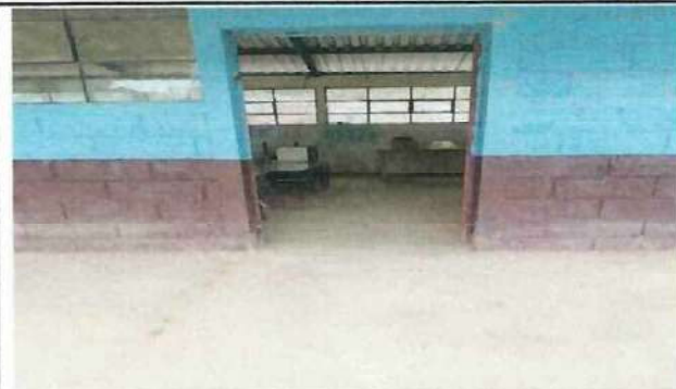
Foto 2: COLOCACIÓN DE PISO CERÁMICO, CAMBIO DE PUERTA Y PINTURA AULA No. 2
