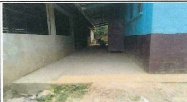
Foto 4: COLOCACIÓN DE PISO CERÁMICO, CAMBIO DE PUERTA Y PINTURA AULA No. 4
