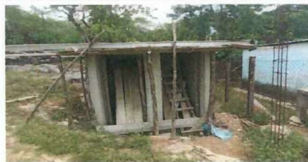
Foto 6: COLOCACIÓN DE 2 PUERTAS DE BAÑOS.
